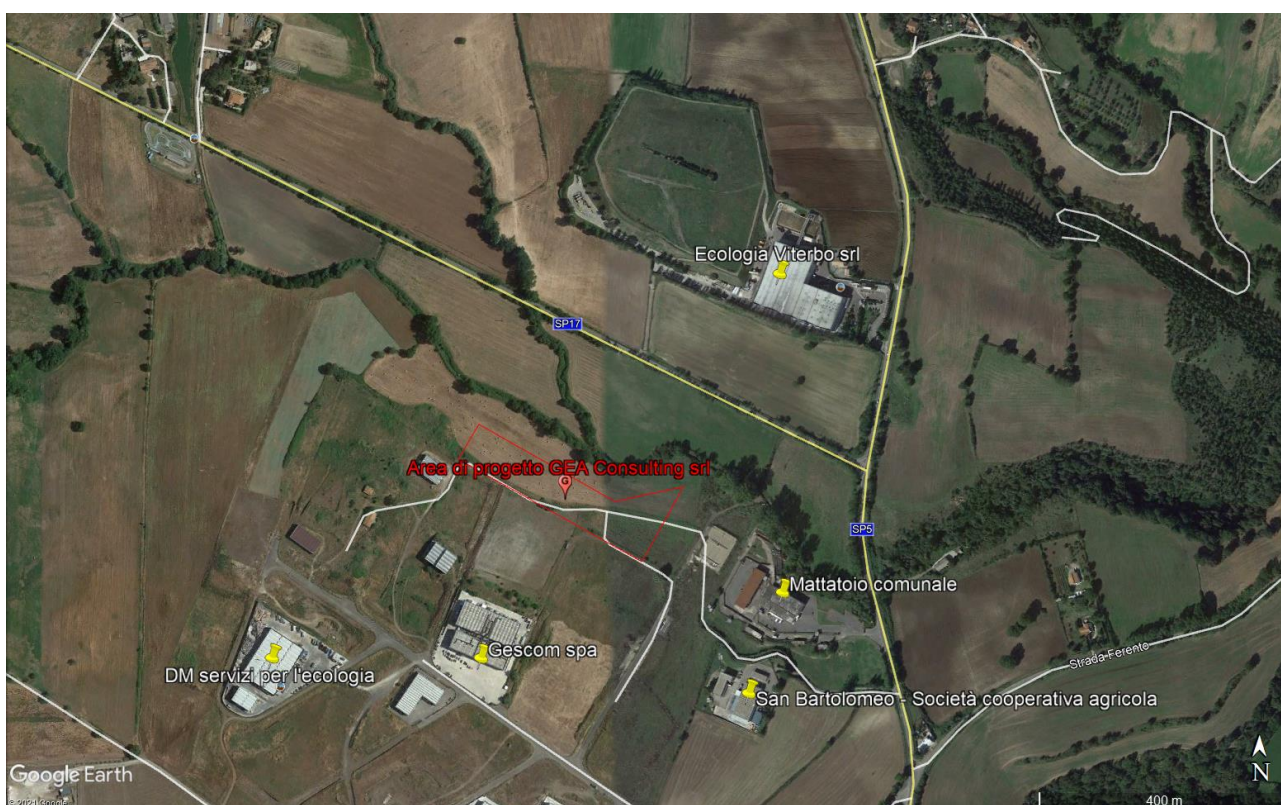
Figura 5.56 - Infrastrutture presenti in un intorno dell'area di progetto.
